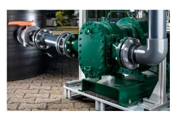
Korthaus Drehkolbenpumpe KD152 in einer Gülleverwertungsanlage © Korthaus Pumpen GmbH / DLR e.V.
